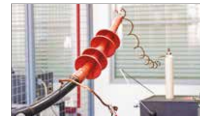
Высоковольтные испытания кабельных муфт
